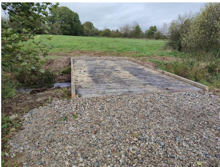
Suppression d'une buse, remplacée par une passerelle bétail – Bassin du Couillard
